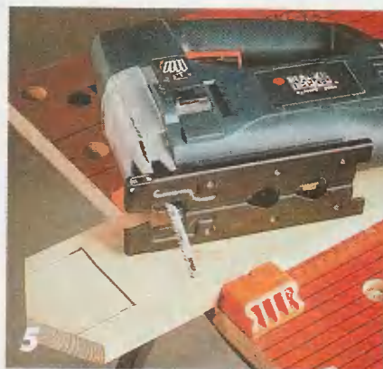
В двух центральных досках фасадов электролобзиком делают вырез для конькового бруса парника.
