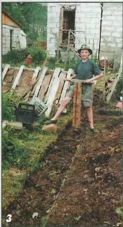
Уплотнение и выравнивание трамбовкой слоя глины.
