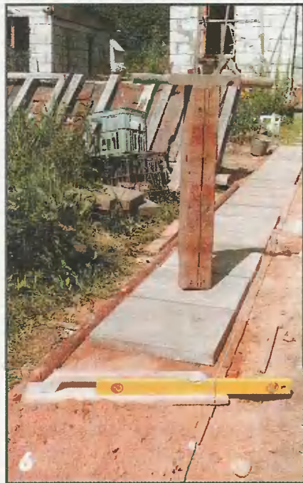
Укладка тротуарной плитки с применением полутерка, уровня и трамбовки.
