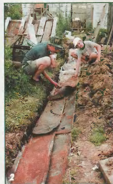
Укладка стеклянных бутылок в траншею.
