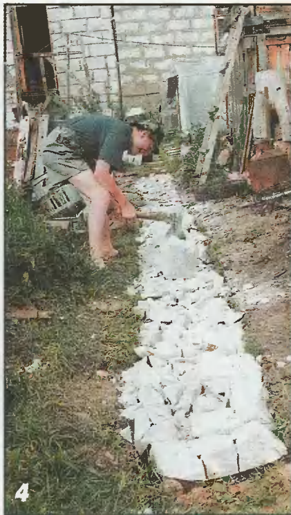
Укладка битых кусков от газобетонных блоков.
