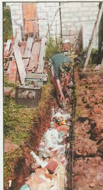
Укладка стеклянных бутылок в траншею.
